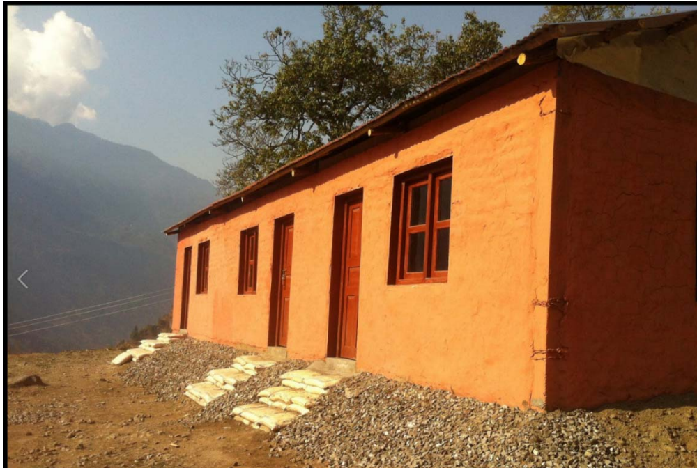
Community Hall en Haku construido por Focus for Nepal en asociación con Trekking Experts
